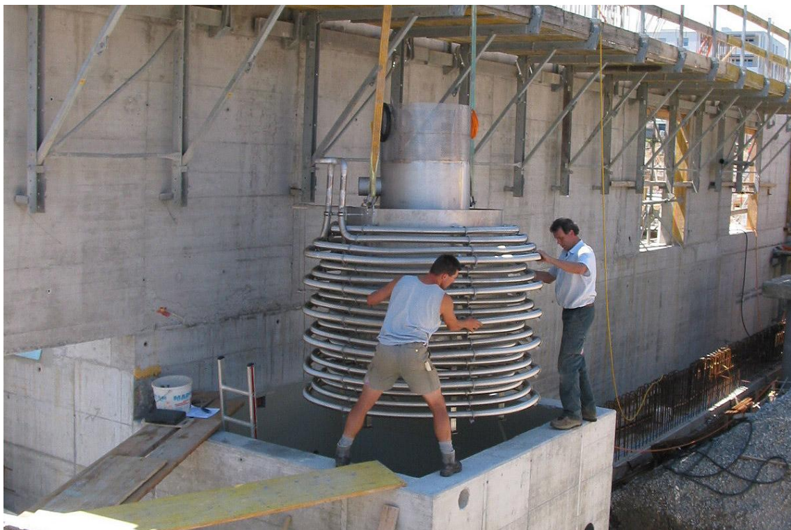
Bild 2: Einbau FEKA-Modul in den Abwasserschacht einer Wohnüberbauung
